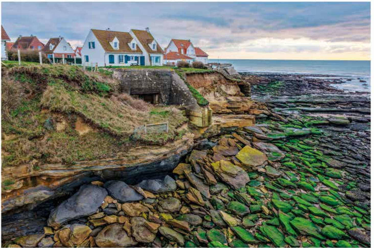
Erosion de la falaise - Audresselles
